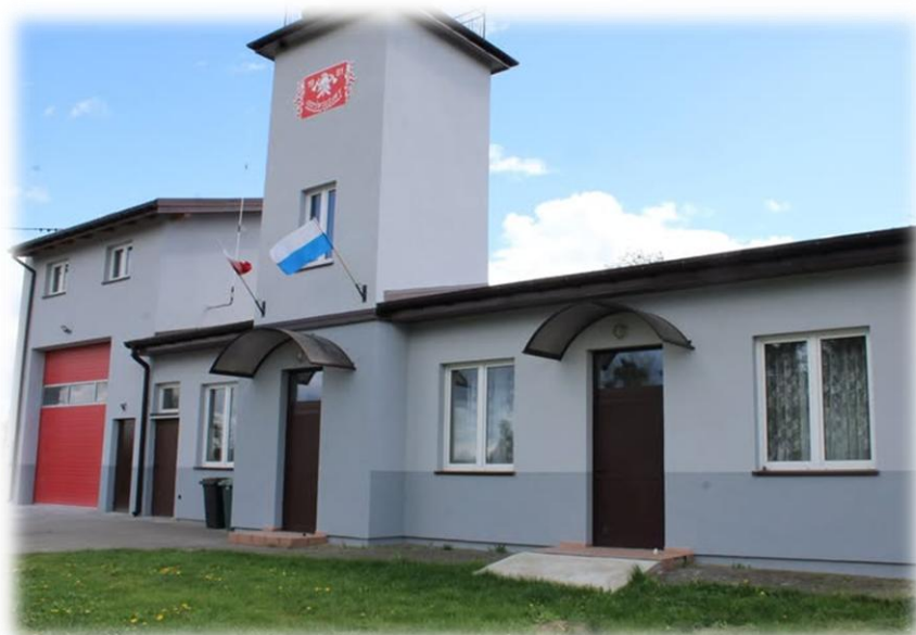
Modernizacja świetlicy wiejskiej w Świeżawach
